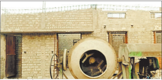
निर्माणधीन पीडीएस भवन।
